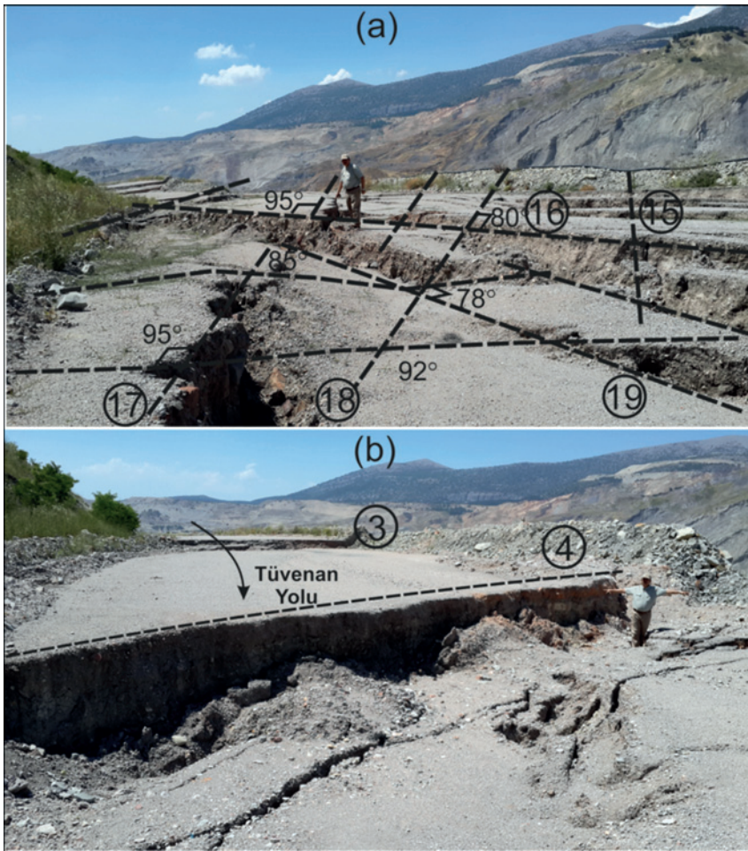
Şekil 12. (a) Fay zonu üzerinde birbirine yaklaşık dik gelişmiş tasman çatlakları (sübsidans çökme bölgesi), (b) Elek yolunu dikine kesen, sübsidans alanının çekme bölgesinde yer alan 3 ve 4 numaralı çatlaklar (fay etki sahasının dışında kalan bölge).
